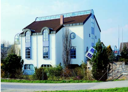
Abbildung 1: Unser Firmengebäude in Marktheidenfeld
